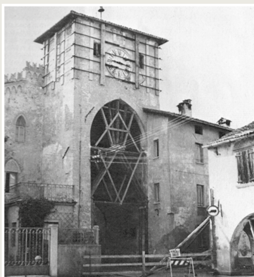
Spilimbergo, la Torre orientale puntellata per garantirne la stabilità.
