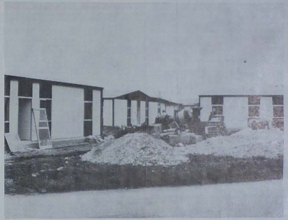
Usago: Ultimi ritocchi ai prefabbricati.
