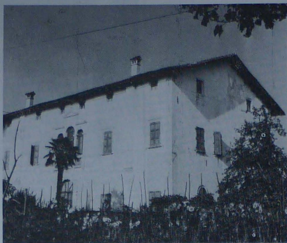
Palazzo Spilimbergo "di Sopra" visto da ovest.
