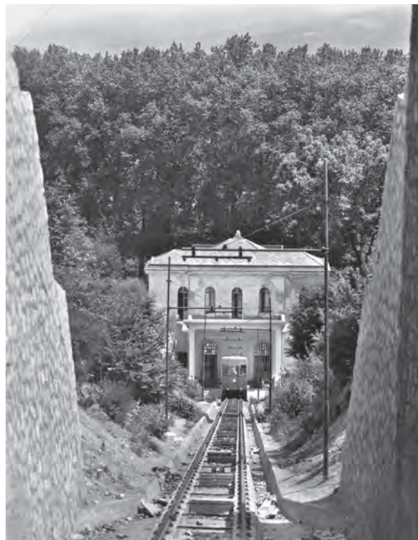
Stazione di Mercogliano, dove arrivava Gina con il treno e da qui, in funicolare, raggiungeva il cantiere di Montevergine, in provincia di Avellino.
