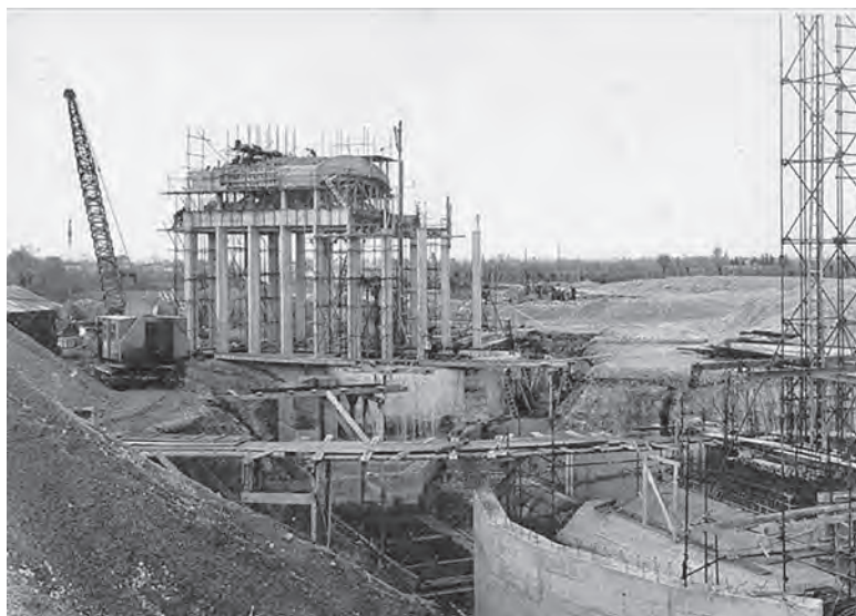
Centrale idroelettrica di Istrago in costruzione (www.istrago.it).
