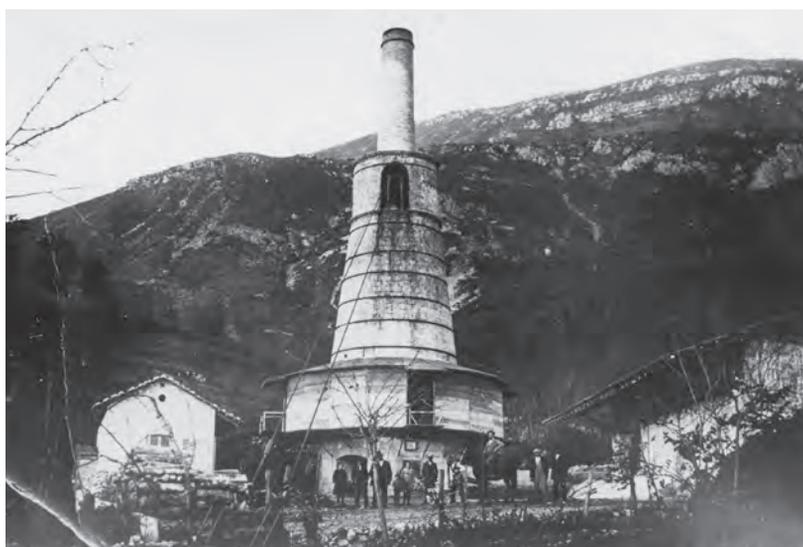
La fornace vista da sud. Si notano i cavi e l'argano dentato, utilizzato nei primi anni per il caricamento dei sassi portati in loco con i carri.
