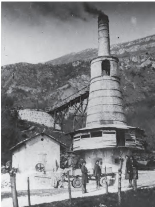
**La fornace in azione. A sinistra si nota il ponte di legno costruito nel 1936 per il trasporto dei sassi.**
