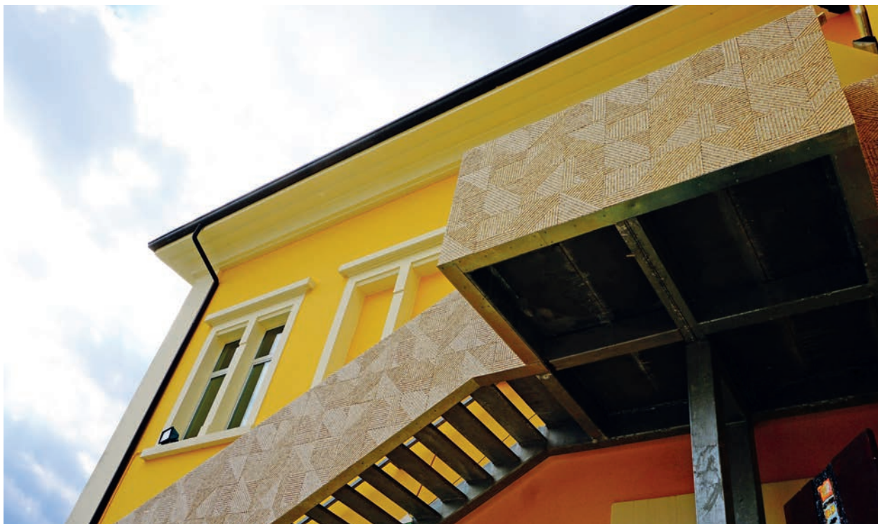
La scala antincendio a lavori eseguiti.
