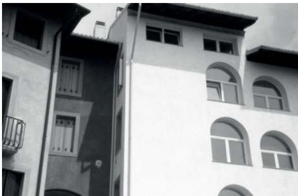
Palazzi nel centro di Gemona, ricostruita dopo il sisma.
