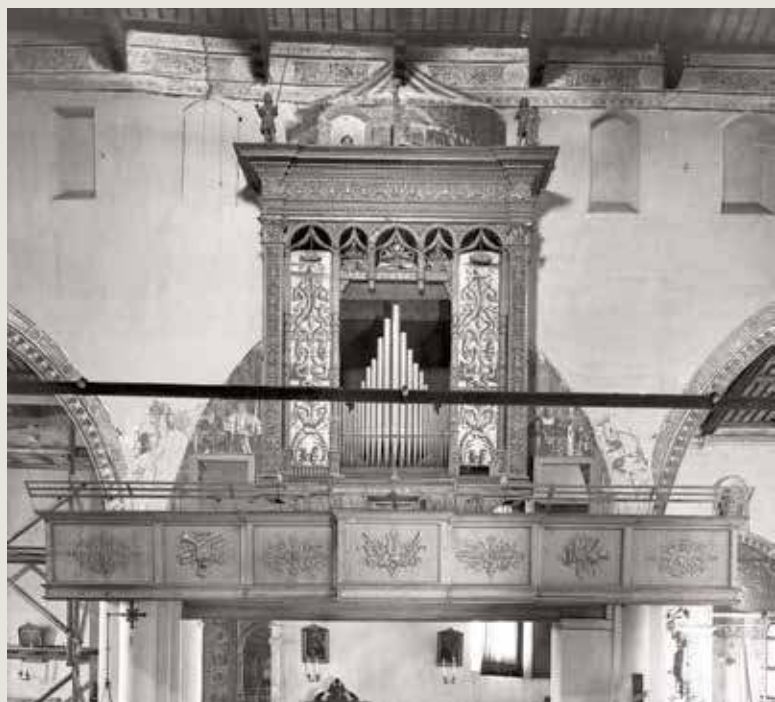
Veduta dell'organo durante i lavori di restauro del 1929-30.
