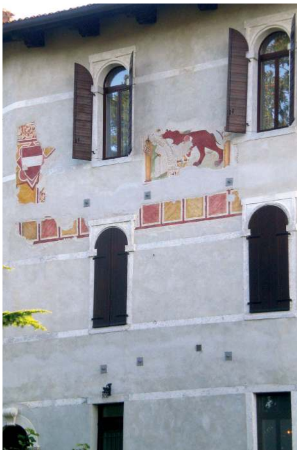
Facciata esterna del castello, lato ovest, con il simbolo degli Asburgo e il leone alato di Venezia.
