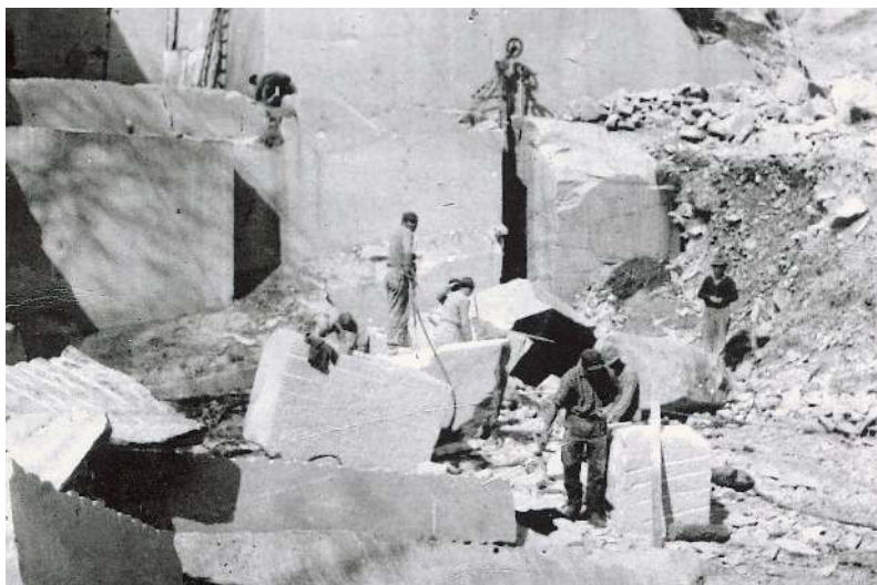
La cava Spessa. Meni Zannier è il personaggio a destra, con la maglia scura e il capello in testa. La cidule che si vede in alto, fungeva da deviatore per il cavo elicoidale usato per tagliare la pietra.
