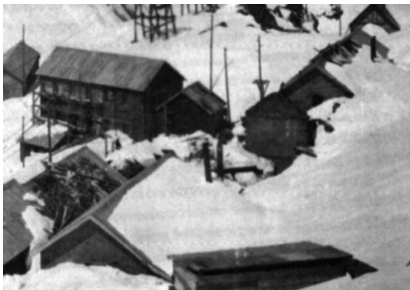
Izourt, 25 marzo 1939: le baracche del cantiere sommerse dalla neve.
