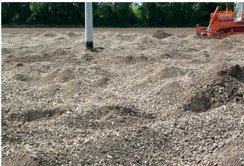
Macchine sterratrici al lavoro in un terreno.
