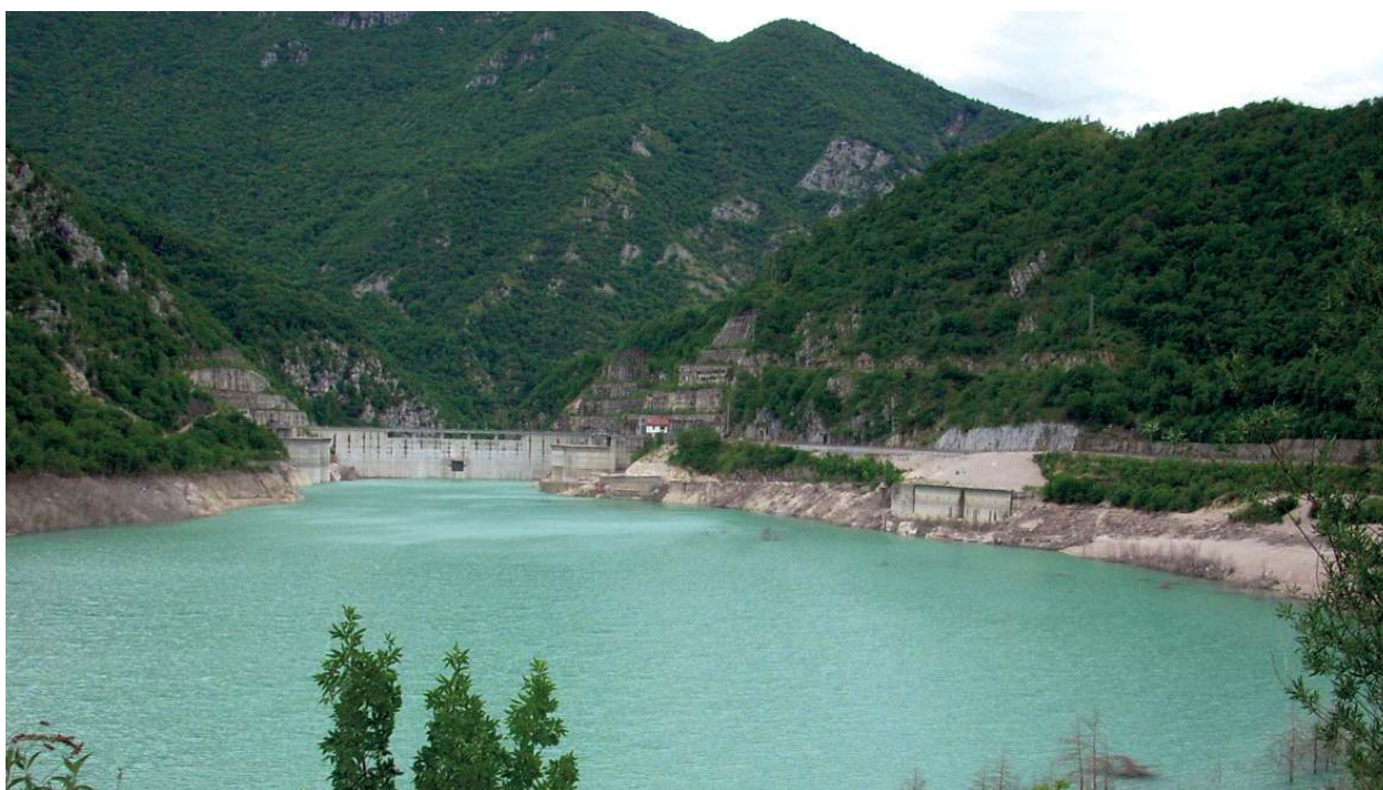
La diga di Ravedis.
