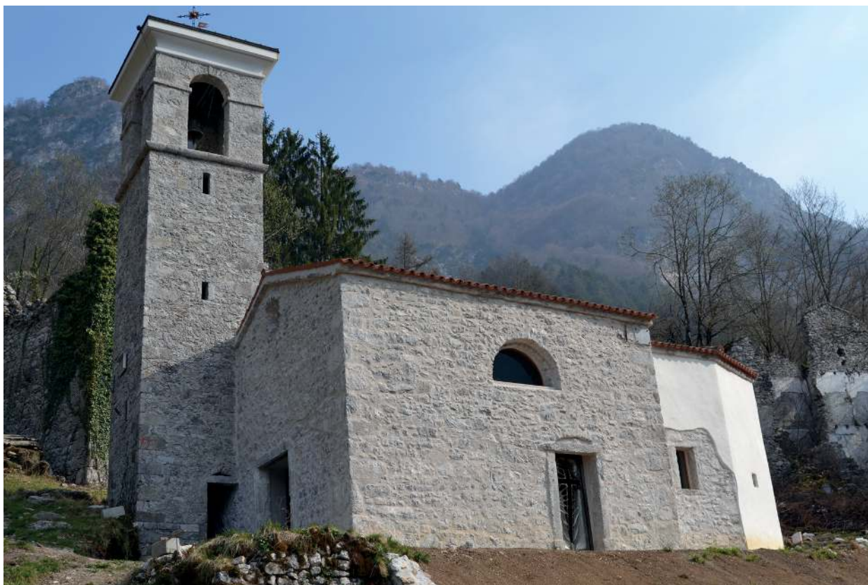
La chiesetta di San Giacomo a Palcoda, al termine dei lavori di restauro.
