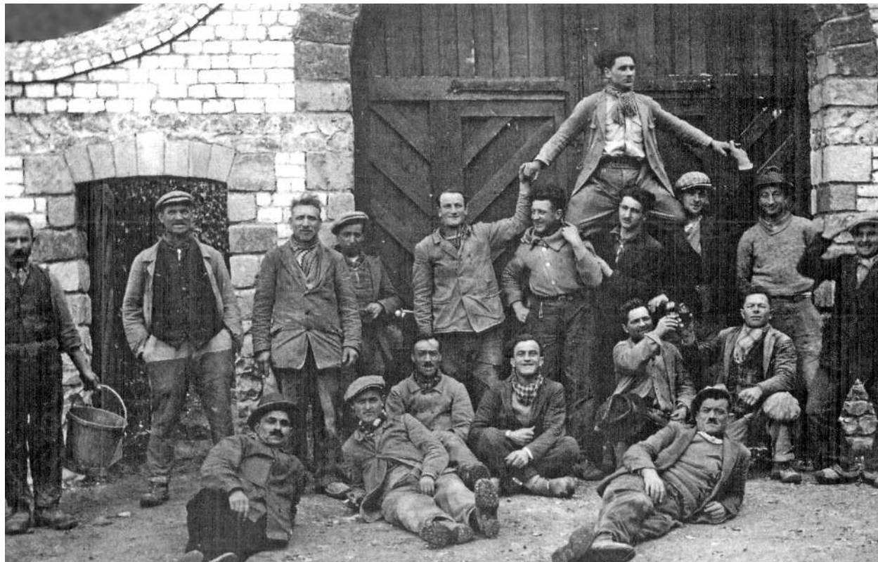
Squadre di muratori partirono dal Friuli alla volta della Francia, per lavoro, agli inizi del '900. Poi seguirono spose e figli (arch. CRAF).
