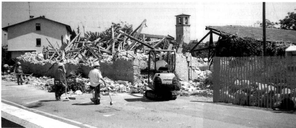
La demolizione della casa dei "Luncs" in via Beato Bertrando, per fare posto a nuove palazzine.
