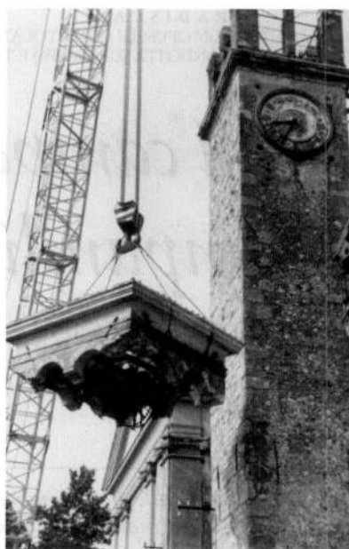
Rimozione della cella campanaria, 1976.
