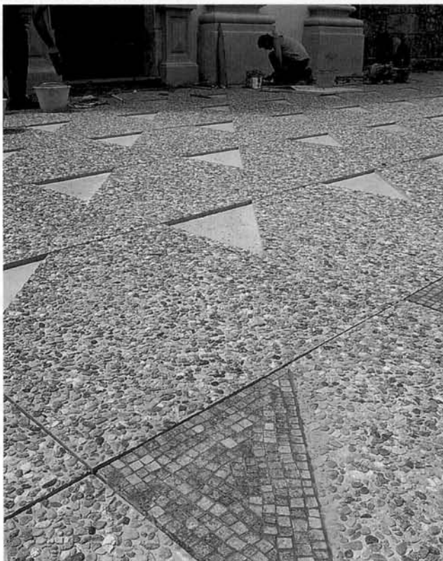
Una fase della realizzazione del sagrato della chiesa di Santo Stefano a Gradisca (arch. SMF).
