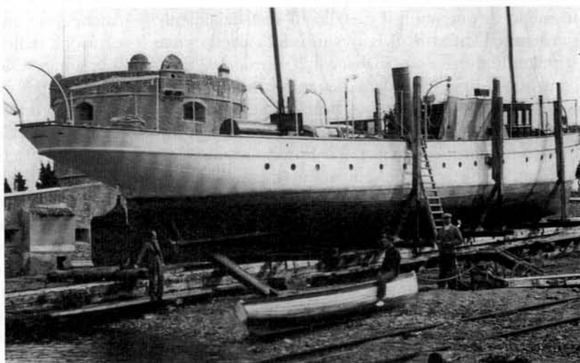
La Bécasse, la barca a vela usata per i lavori alla Grande Ile.
