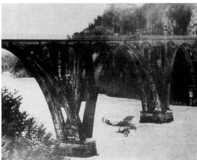
Virtuosismo aereo sotto il ponte di Pinzano negli anni Venti e Trenta (Arch. Aisa).
