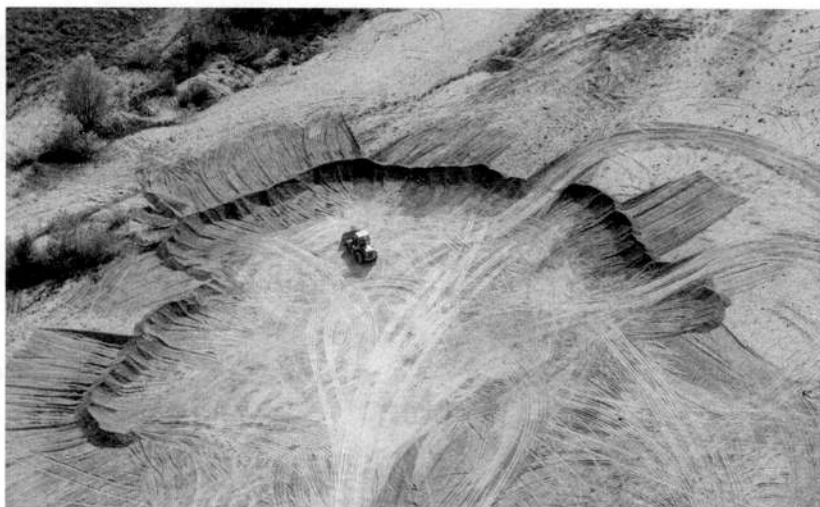
Ruspa al lavoro sul letto del fiume. Cosa accadrà con le casse di espansione? (foto Pietro De Rosa)
