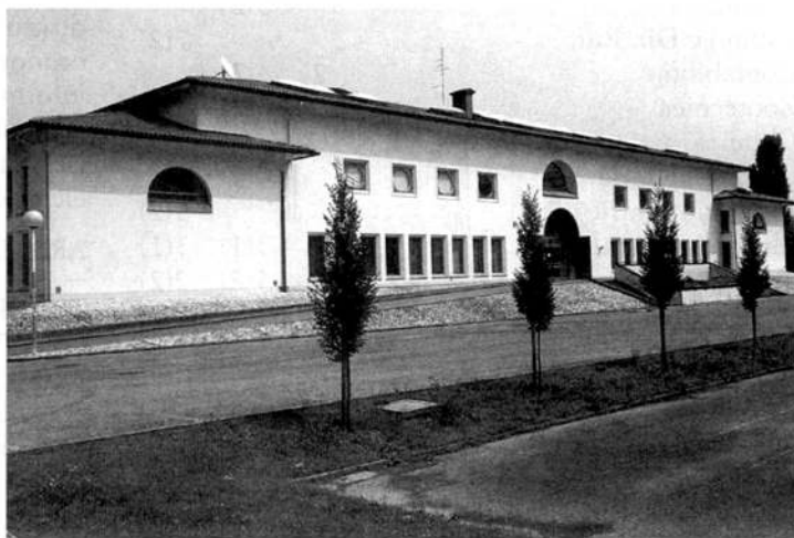
L'Istituto Tecnico Agrario Statale (ITAS).
