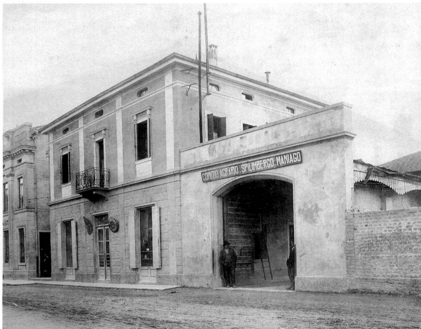
Il Comizio Agrario di Spilimbergo, fondato nel 1881, nella nuova sede di via Cavour. L'edificio, ora demolito, stava nell'area oggi posta tra la Banca Popolare di Verona e la linea ferrata.
