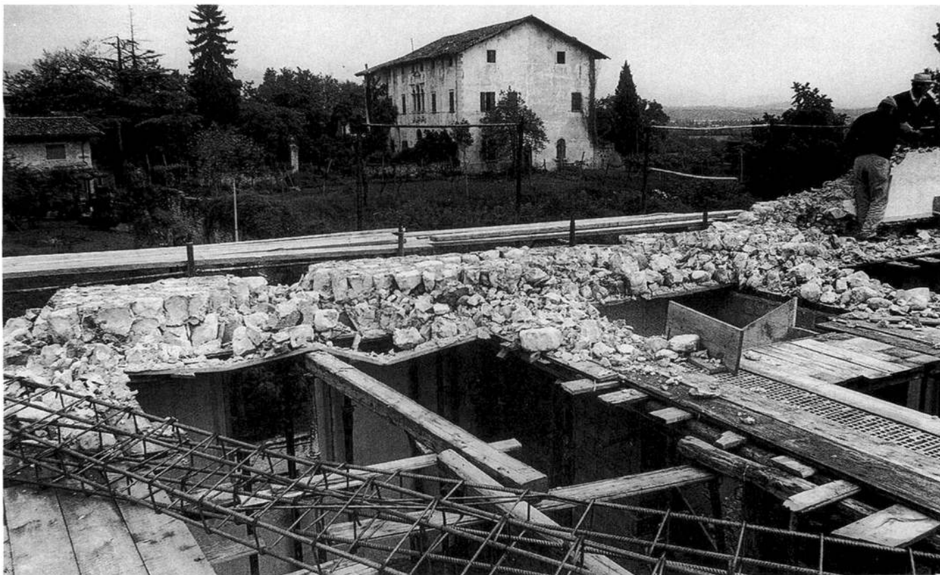
La ricostruzione. Un'immagine dei lavori di consolidamento in casa Cancian a Spilimbergo. Sullo sfondo Palazzo di Sopra.
