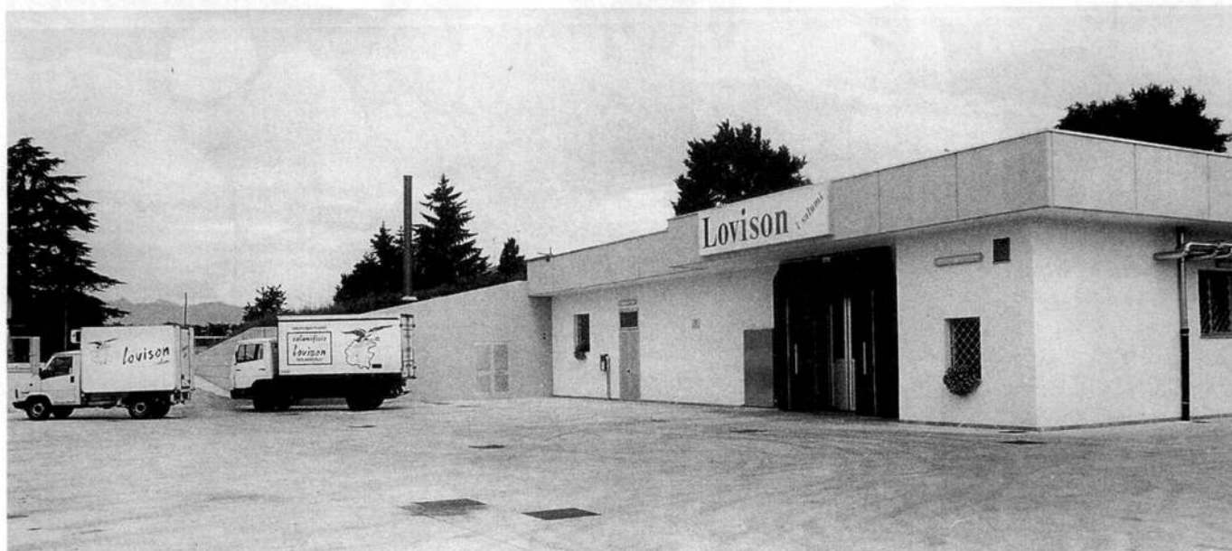
Facciata e piazzale del nuovo salumificio Lovison. (Servizio fotografico di Gianni C. Borghesan)
