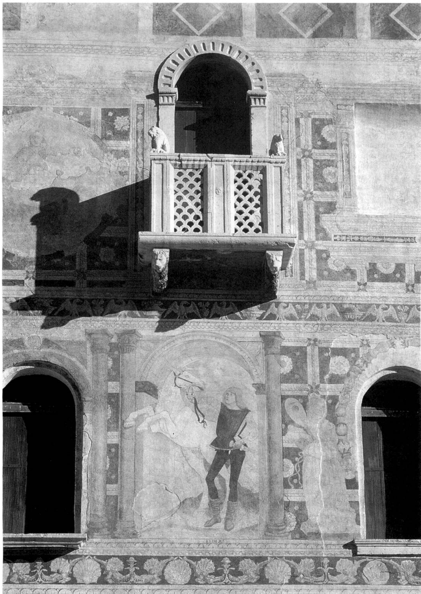
Palazzo Dipinto. Particolare della facciata restaurata e palafreniere con la divisa degli Altan. (Foto Giuliano Borghesan)
