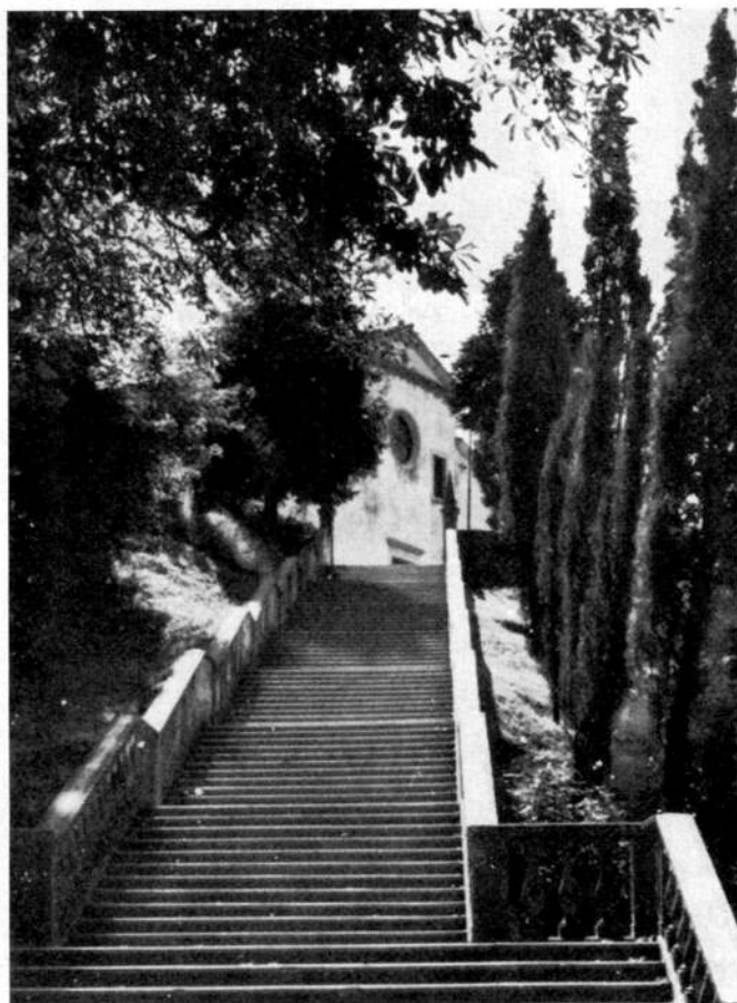
La scalinata d'accesso alla chiesa di San Giacomo.
