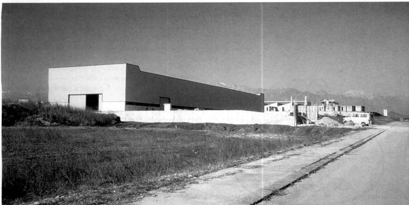
Il capannone della ditta "Liva s.p.a."
