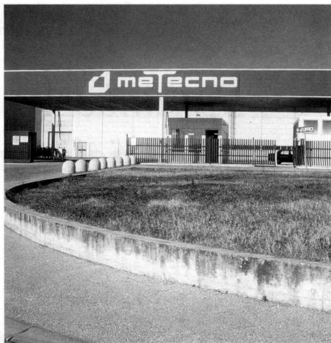
Il capannone della ditta "Metecno".
