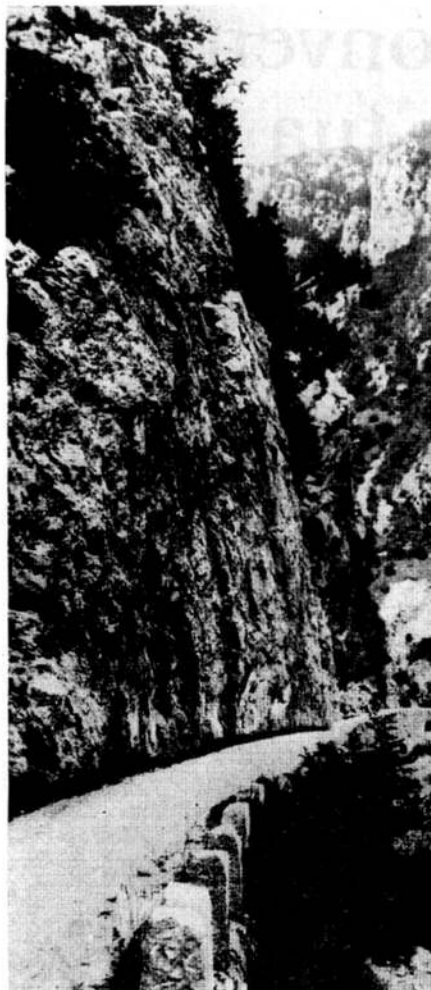
Vecchia cartolina illustrata che evidenzia la carreggiata, i fitti paracarri e l'enorme lavoro di sbancamento necessario per ricavare la sede stradale.
