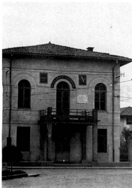
La sede della Società Operaia di Tauriano prima degli interventi di ristrutturazione.
